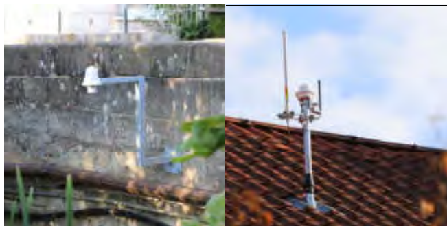
Der Pegelsensor der Seebach (links) und der Mast mit Antenne und Regensensor auf dem Dach der Bauhof-Fahrzeughalle sind Komponenten des Starkregenfrühwarnsystems der Gemeinde. (Fotos: VG Heßdorf/Brehme)
