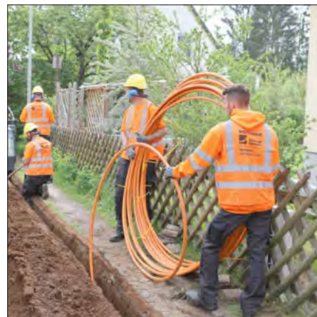
Glasfaser-Verlegearbeiten durch einen Bautrupps der Firma Deutsche Glasfaser.
