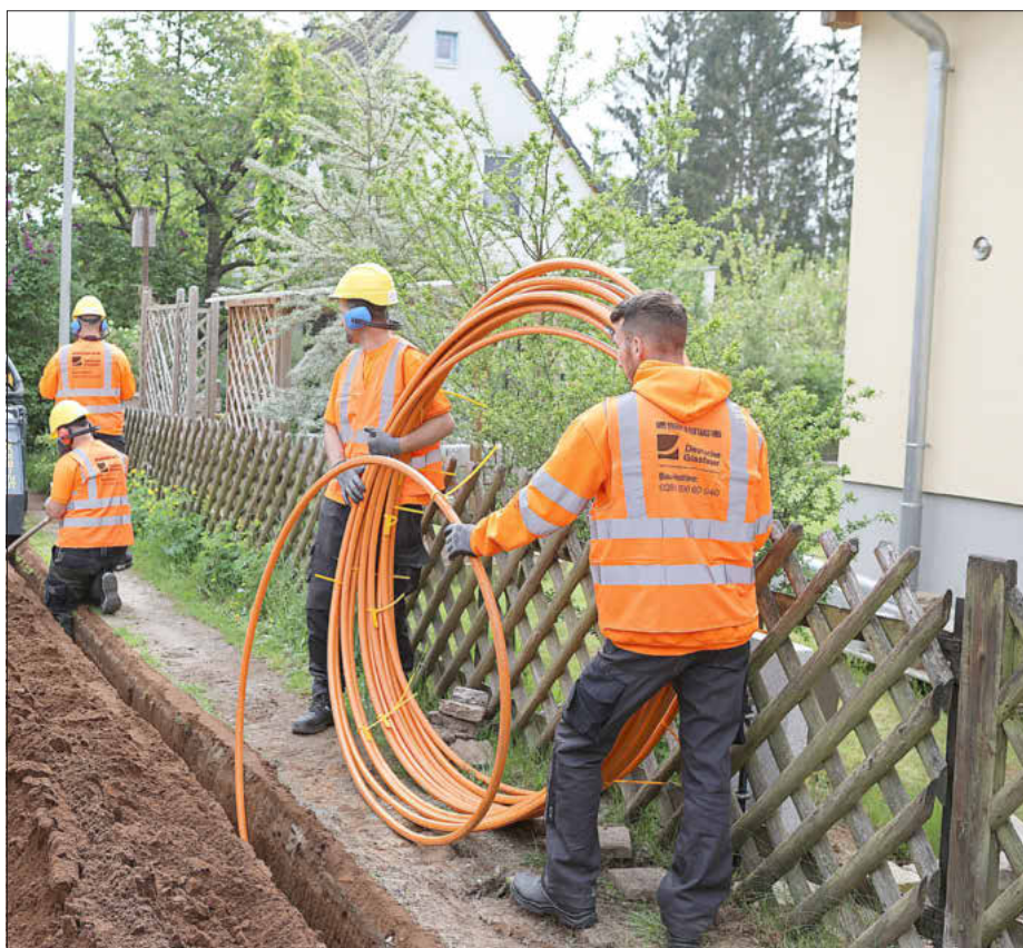
Glasfaserverlegung in einer Gemeindestraße durch die Deutsche Glasfaser
