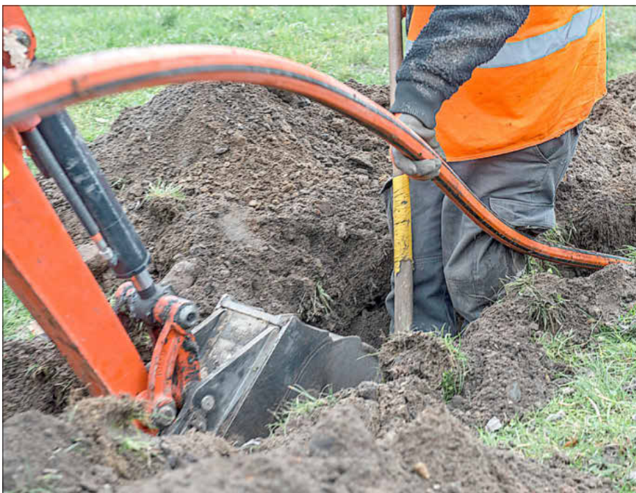
Tiefbauarbeiten zur Verlegen eines Glasfaserkabels
