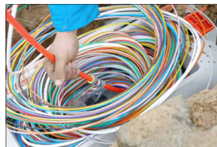
Netzausbau mit Glasfaser
