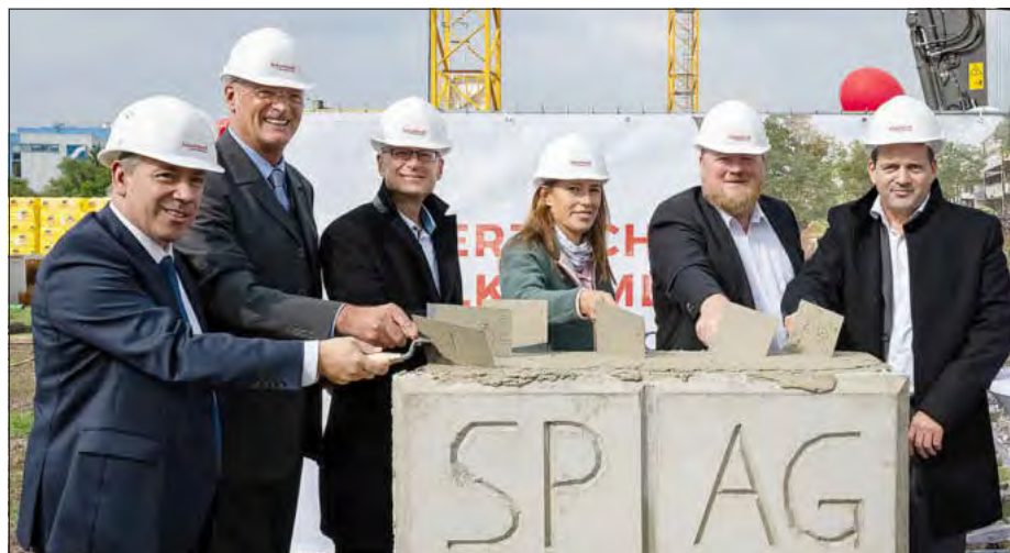
Bei der symbolischen Grundsteinlegung vermauerten Landrat Alexander Tritthart, Dr. Hermann Ruttmann (Vorstandsvorsitzender Schultheiß Projektentwicklung AG), Ralph Büchele (Geschäftsführer BayernHeim GmbH), Anja Willert (Dritte Bürgermeisterin Heßdorf), Axel Gotthardt (Zweiter Bürgermeister Heßdorf) und Jürgen Buchta (Geschäftsleiter Mauss Bau GmbH & Co. KG) die Zeitkapsel im Grundstein des Geschosswohnungsareals.
