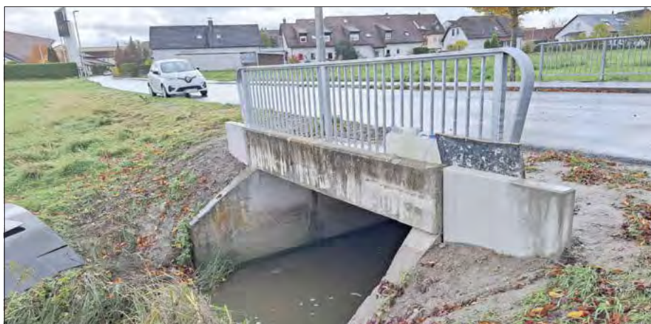
Auf dem Foto waren die Sanierungsarbeiten am BW014 in der Neuen Straße in Großenseebach noch nicht ganz abgeschlossen. Fotos (5): Stefan Damm/VG Heßdorf
