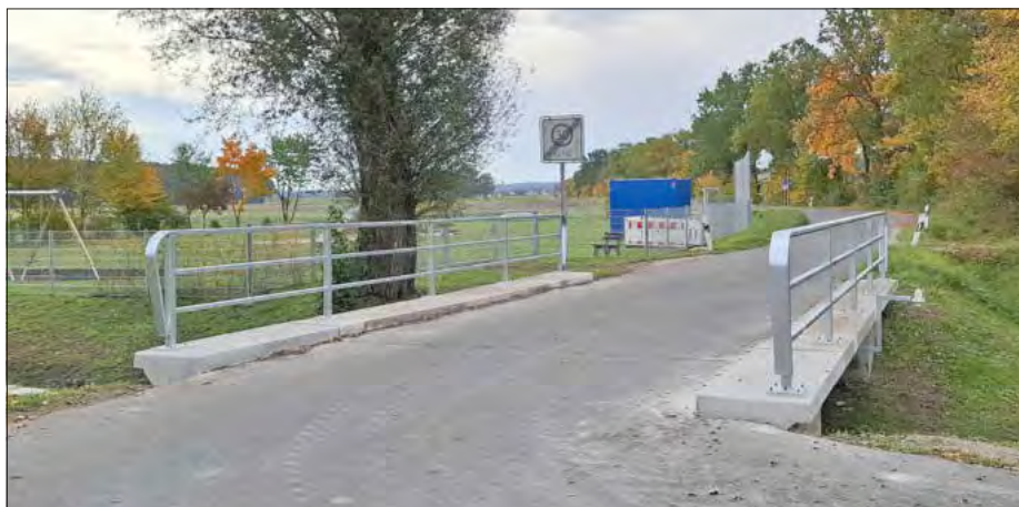
Das Brückenbauwerk BW011 geht auf der Straße zwischen Hesselberg und Dannberg über den Mohrbach.
