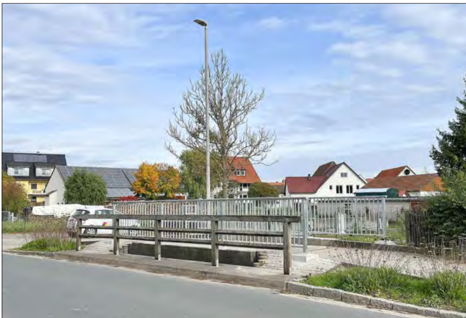
Das sanierte Brückenbauwerk BW 005 in der Klebheimer Straße in Niederlindach.
