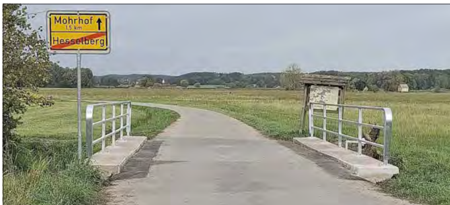
Das BW009 am Ortsausgang Hesselberg in Richtung Mohrhof
